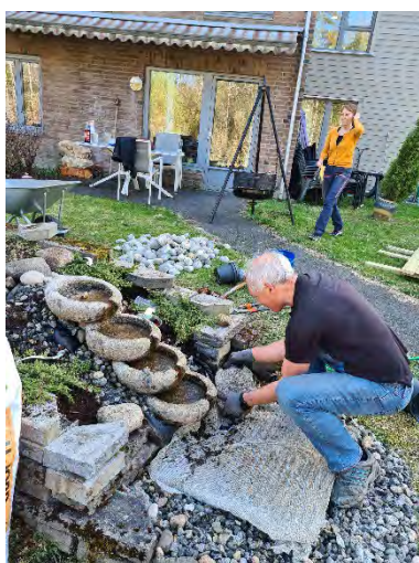
Vannfallet sildrer og får ny sten og beplantning.
